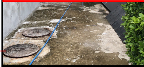
จุดที่ 3 บ่อตรวจคุณภาพน้ำทิ้งหลังออก จากระบบบำบัดน้ำเสีย (อาคาร A)
