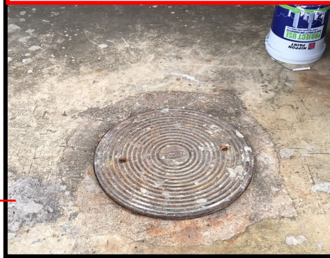
จุดที่ 3 บ่อตรวจคุณภาพน้ำทิ้งหลังออก จากระบบบำบัดน้ำเสีย (อาคาร A)
